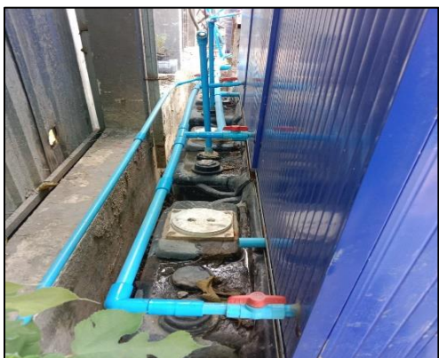
ภาพที่ 9.ระบบบำบัดน้ำเสียจากห้องน้ำ
