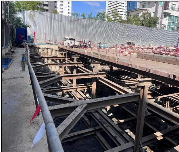
ภาพที่ 23.เหล็กค้ำยันกันทรุด
